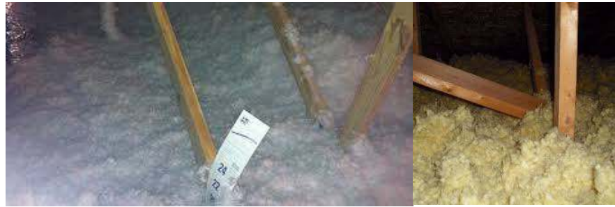
Loose fill fiberglass
